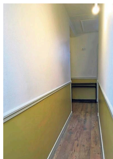
De monumentale gang van het kantongerecht werd beschilderd met koolstofverf (links) en geeft nu warmte af. Geen radiator te zien.
